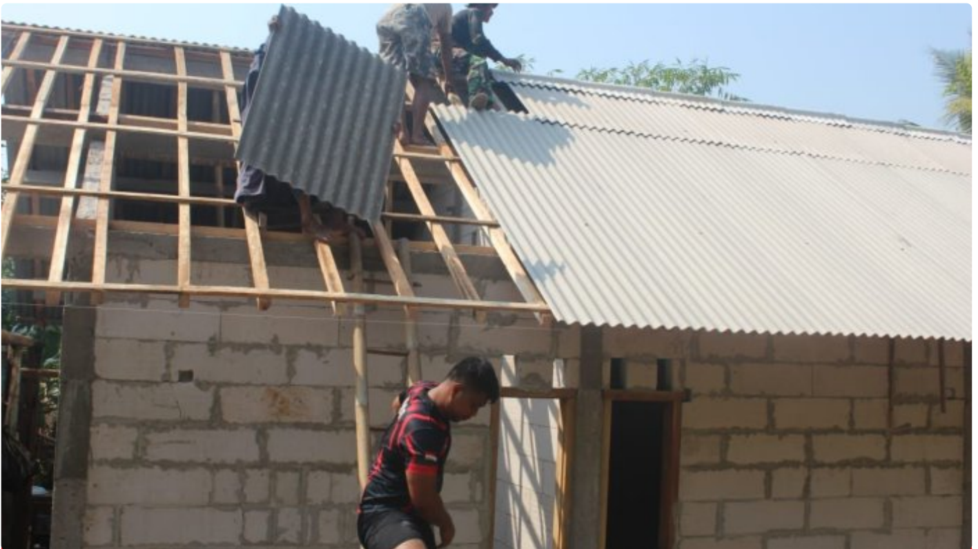
Pengerjaan RTLH Desa Pejengkolan Sudah Mulai Pemasangan Atap Rumah
