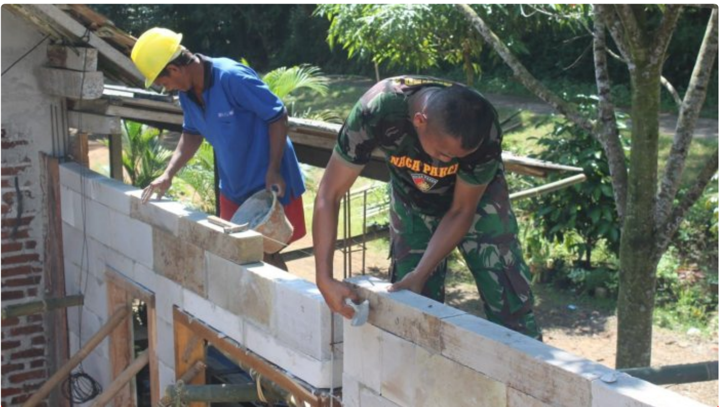
Pemasangan bata di rumah Bp Riyanto pembangunan RTHL
