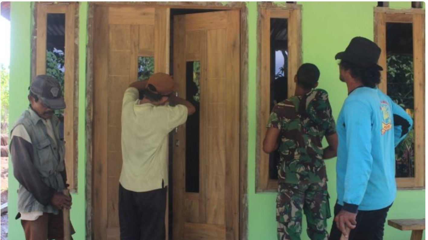
Kegiatan pemasangan daun pintu dan jendela rumah yang bertempat di Desa Pejengkolan
